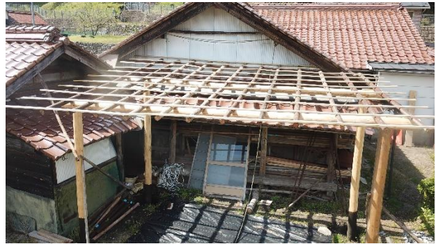
↑波板をかけて完成する直前
