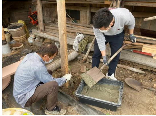
↑柱を立てた穴に、セメントを流し込む様子
