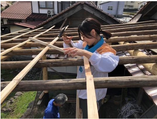
↑屋根の柱を組む様子
